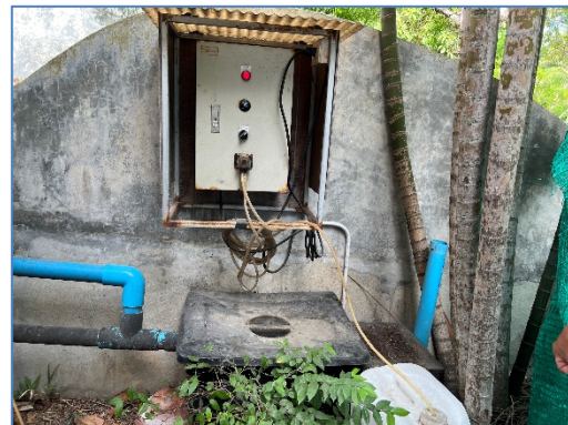
ภาพถ่ายที่ 2.2-8 ถังตกไขมันและการจ่ายสารเคมีเพื่อตกจับไขมันเบื้องต้น
