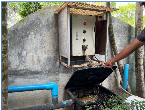
ภาพถ่ายที่ 2.2-8 ถังตกไขมันและการจ่ายสารเคมีเพื่อตกจับไขมันเบื้องต้น
