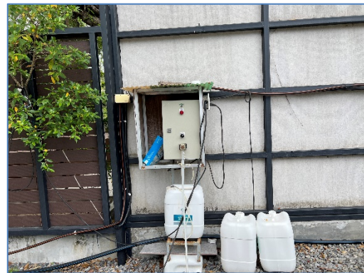
ระบบบำบัดน้ำเสียและสารเคมีที่เติมในบ่อพักน้ำทิ้งสุดท้าย
