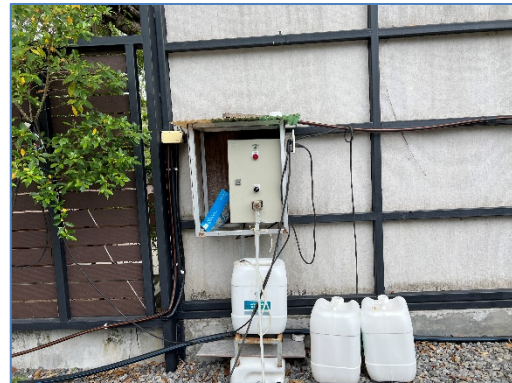
ภาพถ่ายที่ 2.2-7 ระบบบำบัดน้ำเสียและสารเคมีที่เติมในบ่อบำบัดน้ำทิ้งสุดท้าย
